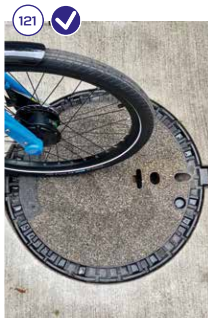
La surface du tampon Pamrex Grip Top multiplie par deux les performances d'adhérence des pneumatiques.
