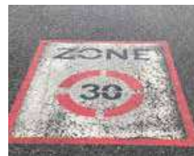
Marquage d'entrée en " Zone 30 ".
